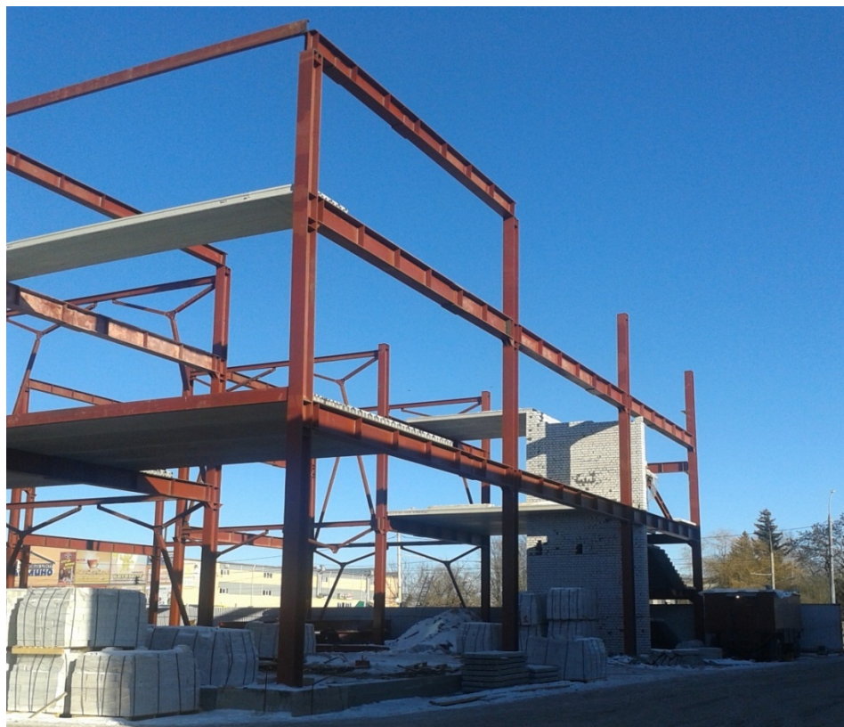
Рис. 2.10. Торцовая поперечная рама здания
